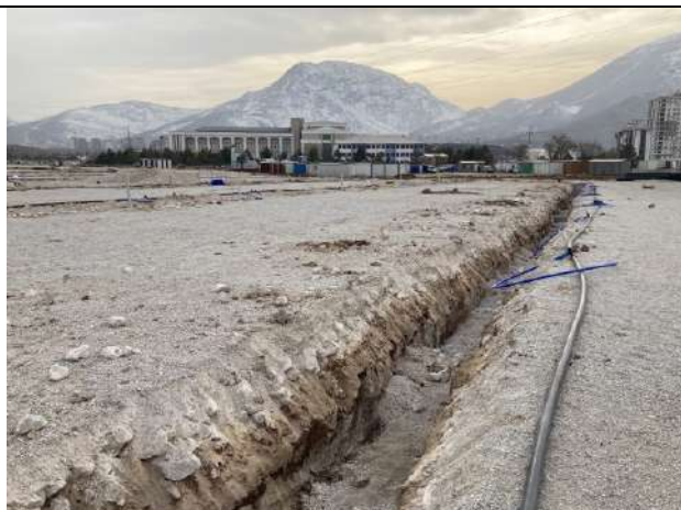
2000棟の仮設コンテナが設置される場所では、インフラ整備のための工事が開始されていた（2023年2月）
